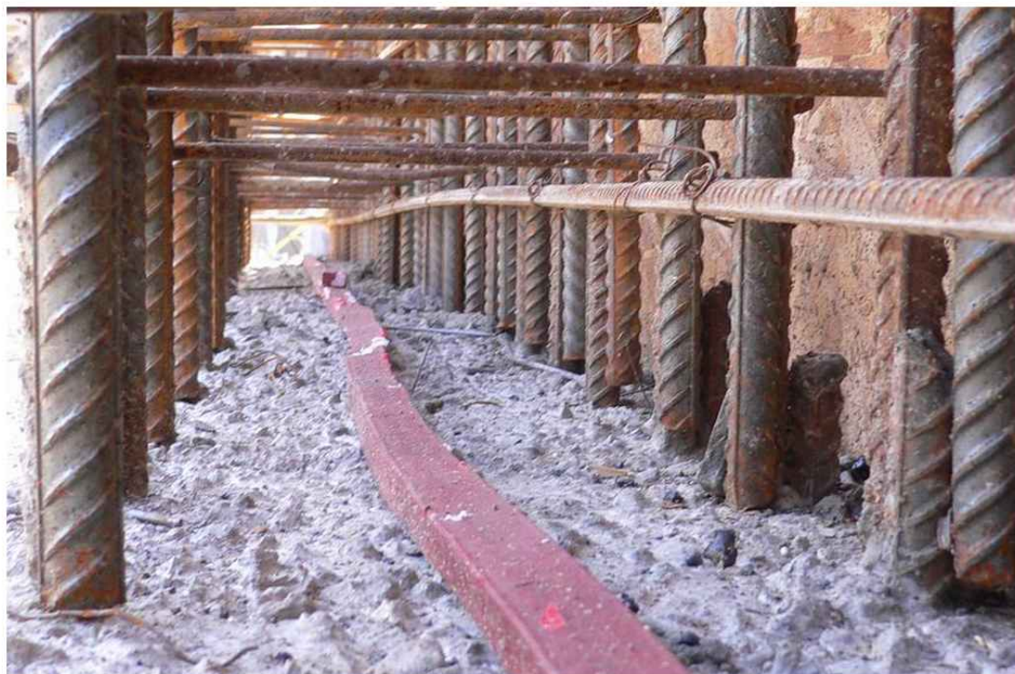
Монтаж бентожгута Гидрофест, при устройстве стыка плиты фундамента и вертикальной ж/б стены
