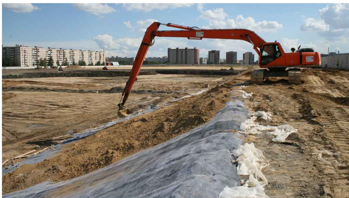
Гидроизоляция откосов котлована при проведении инженерной подготовки территории квартала 9А-СУН на месте бывшего золоотвала, Санкт-Петербург
