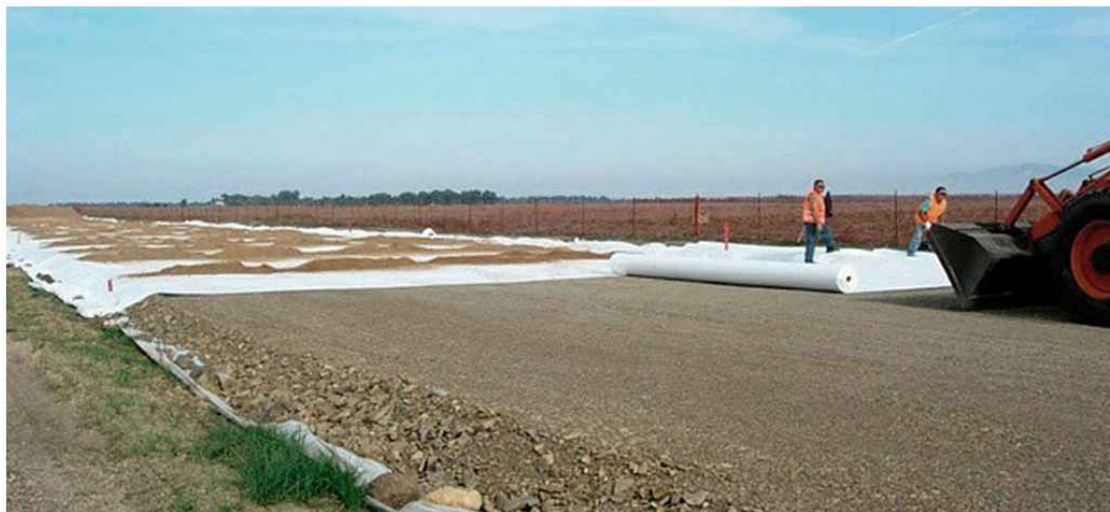
Применение нетканых материалов при формировании дорожного полотна
