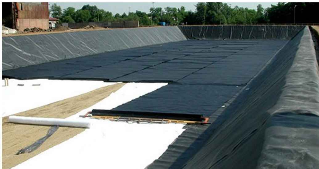
Обустройство поверхности откосов и днища котлованов
