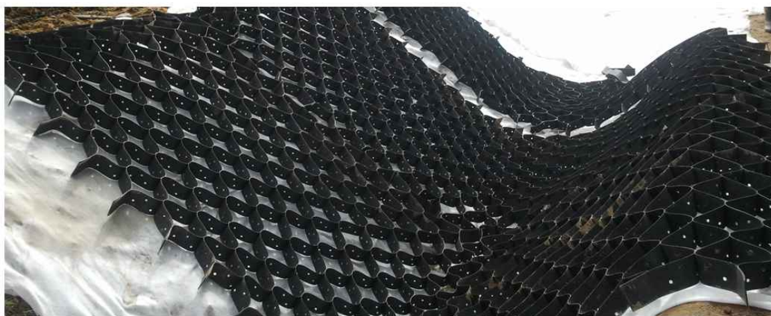
Укрепление откосов объемной георешеткой
