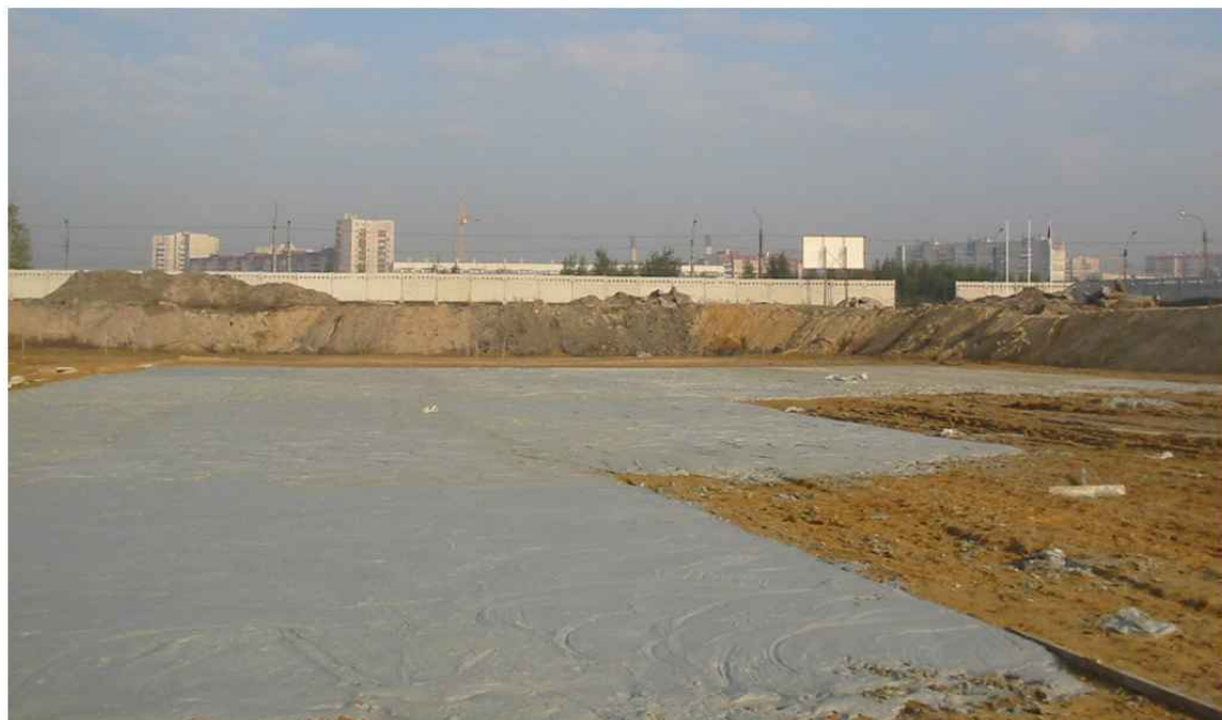
Формирование горизонтального противодиффузионного экрана из ГУТГ
