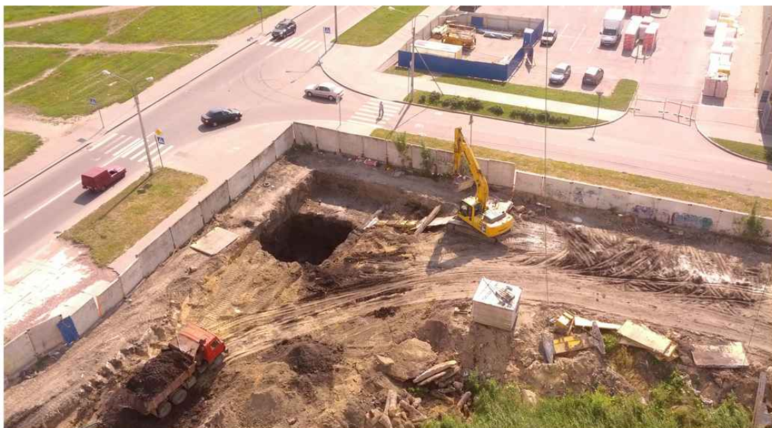
Выборка грунта на глубину 11 м в межсотовом пространстве под защитой подпорных стен из ГУТГ
