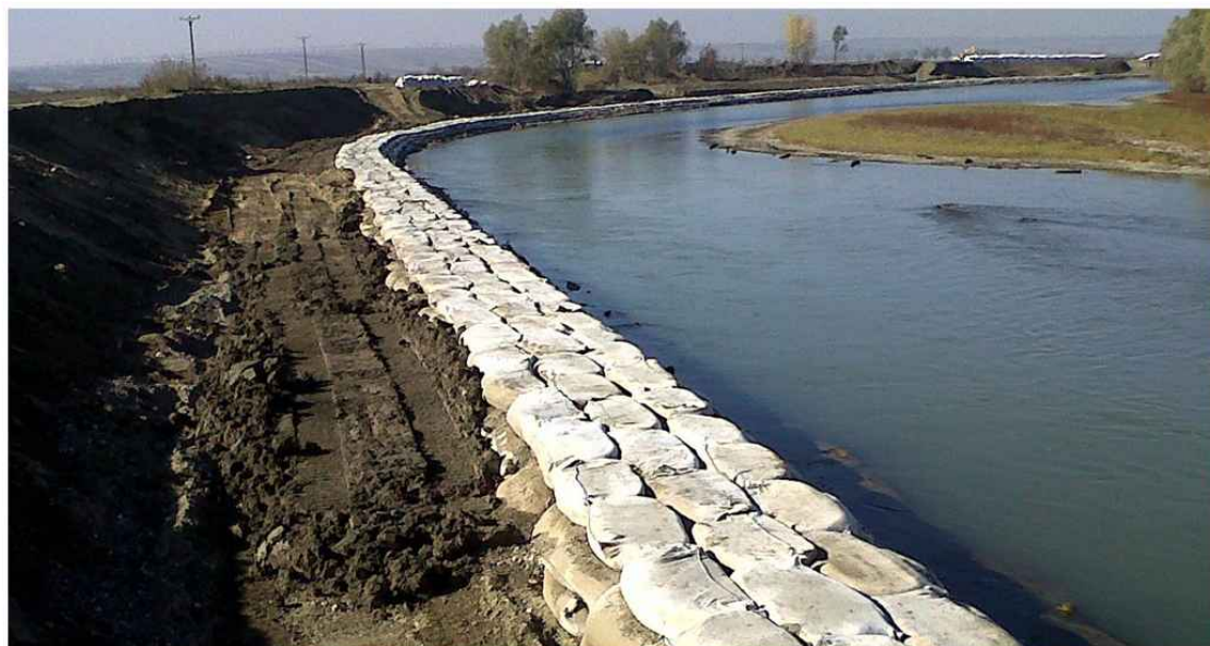
Берегоукрепление с применением геосинтетических материалов
