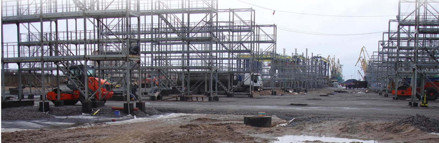
Изначальное состояние трассы газопровода
